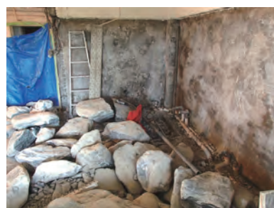
岩風呂(解体中)
