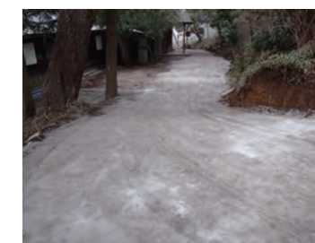
アプローチ舗装(完成)
