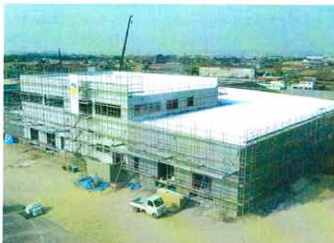
平成24年春の竣工に向け施工中
