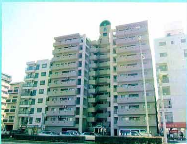
サンワプラザ神戸Daikutsu大規模修繕工事 発注者:サンワプラザ神戸Daikutsu管理組合様 2011年5月
