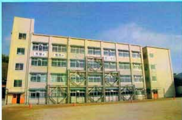
垂水中学校 耐震補強工事 発注者：神戸市 2010年1月 阪神淡路大震災以降、懸案となっていた学校校舎の耐震補強工事。子供達も安心して勉学に励むことができるようになりました。
