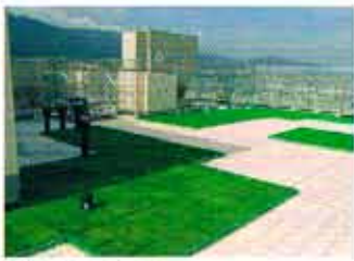
高層マンション屋上
