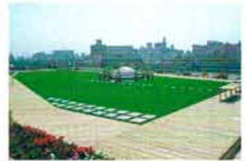
姫路総合庁舎屋上緑化
