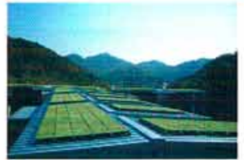
県営住宅屋上緑化
