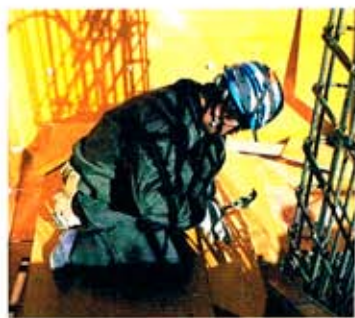
マンションの建設現場で作業する出雲直人さん。ささいな雑音も見逃さない慎重な仕事ぶりで、周囲の信頼も厚い。
