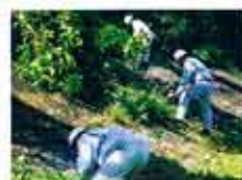
河床および法面の伐採作業
