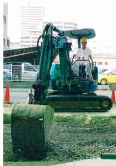
駐車場の土間の整地
