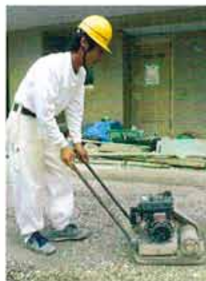
砕石の転圧作業
