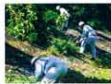
河床および法面の伐採作業
