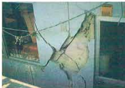
破片が下に落下すると二次災害が心配される外壁
