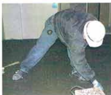
床面を鏝ひとつで水平に ならしていく様子が見事!
