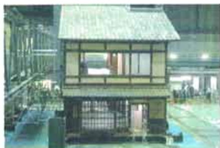
移築された京町屋(実験前)
