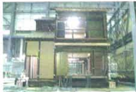
大震災にも耐えうる伝統軸組構法木造住宅(実験後)
