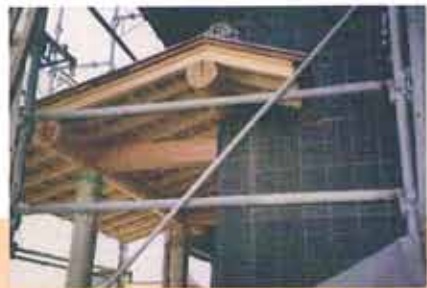
西区春日台5丁目にて建設中の1棟目の軸組構法住宅
